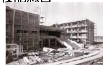
建設中の平方小（越谷市HPより）
